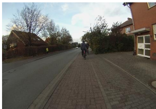
Abb. 3.5-3 Getrennter Geh- und Radweg, Windmühlenweg (Einrichtungsverkehr) (eigene Aufnahme)
